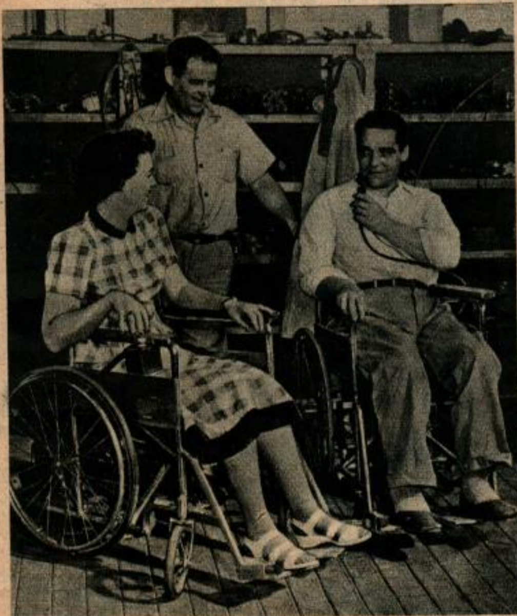
Le personnel du laboratoire essaie lui-même un vêtement sans manches fait avec une étoffe métallisée et qui conserve la chaleur du corps. Ci-dessous, les chaises pour malades sont actionnées par un seul doigt (à gauche) ou en soufflant dans une embouchure (à droite).
