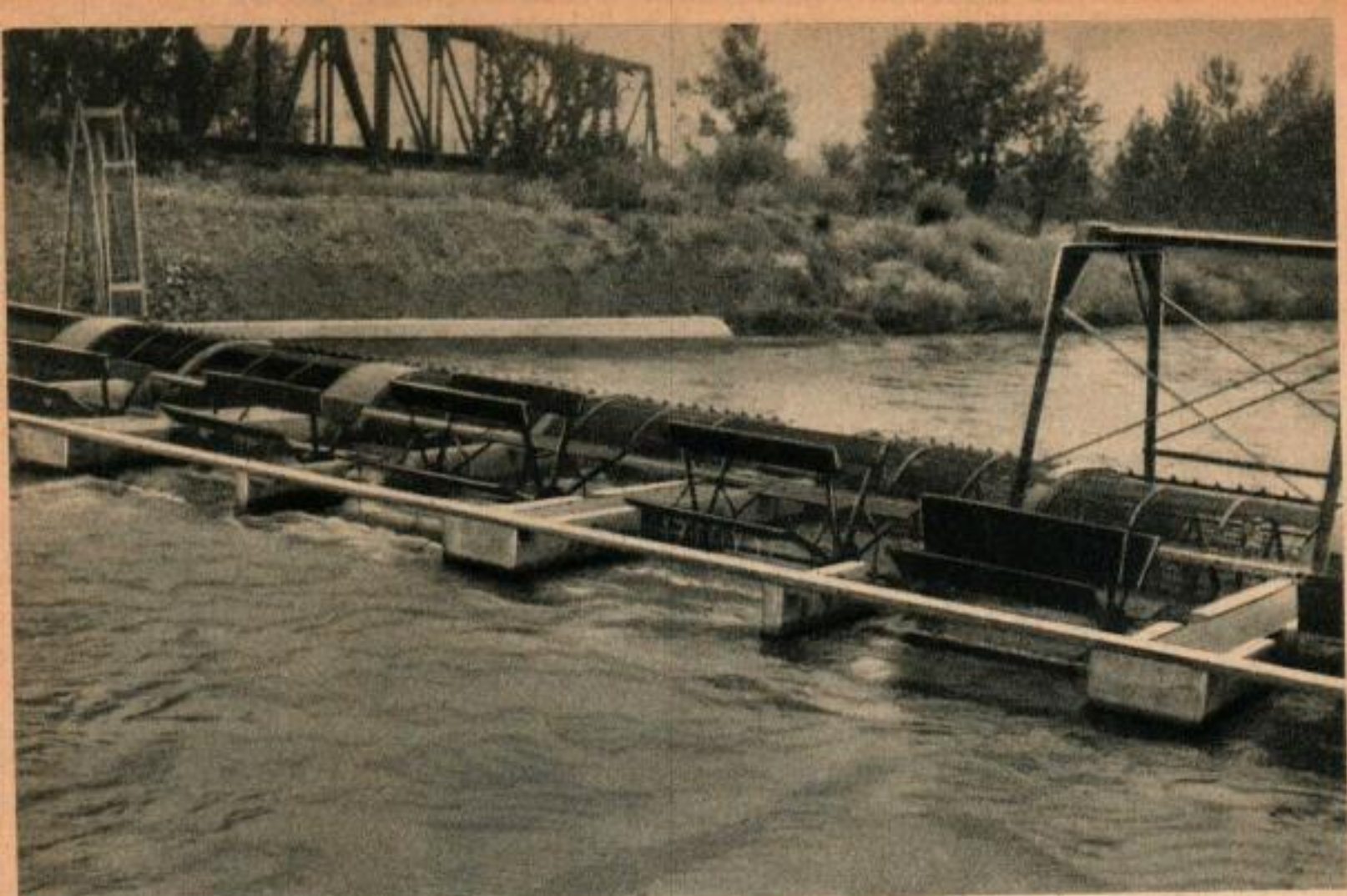
Des écrans rotatifs empêchent les jeunes saumons de pénétrer dans les canaux d'irrigation. Ils seront utilisés contre les lamproies.
