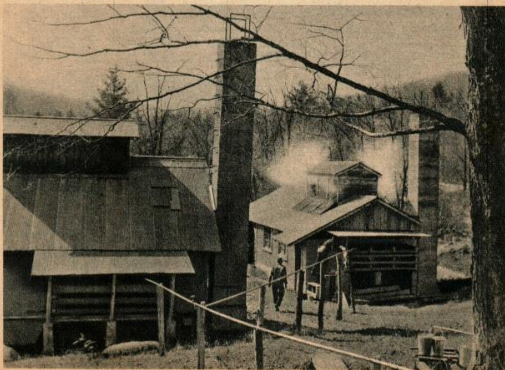
Le transport de la sève dans le bas de la vallée est plus facile qu'autrefois. Il y a 10 km de tuyaux à cette ferme. Chaque canalisation principale est numérotée et les marques sont placées assez haut pour que la neige ne les cache pas. Ci-dessous voici l'arrivée du pipe-line; c'est ici que par ébullition, on en fait du sirop. Deux fermes produisent ici 3 600 litres de sirop par an. Même les arbres au premier plan ont été percés.
