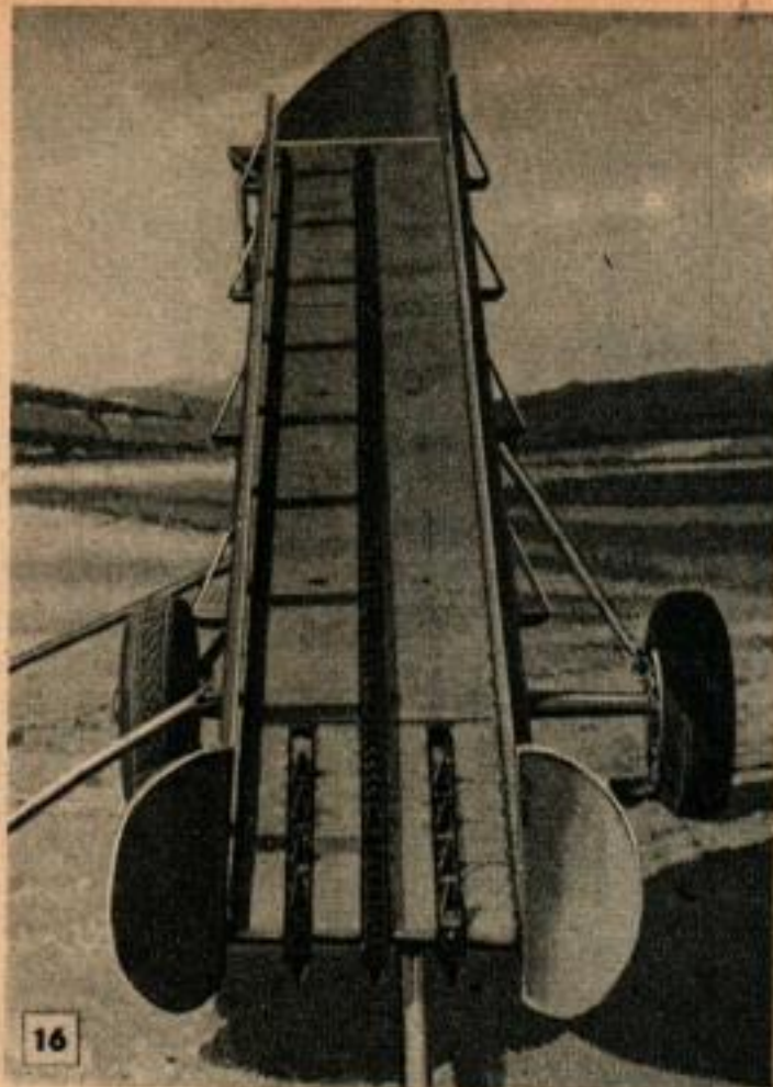
Les chaînes de ramassage (chaînes courtes) mettent la balle de foin en place sur le plan incliné et la chaîne centrale la monte jusqu'à la plate-forme du sommet.
