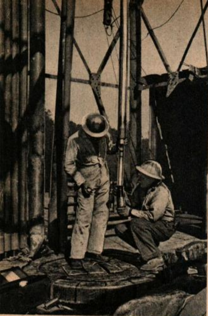
Les ingénieurs vérifient la montre de l'appareil indiquant la verticalité du forage. L'appareil enregistre photographiquement la direction et l'inclinaison du trou.
