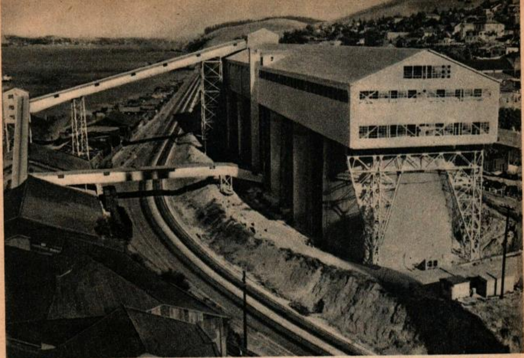
Voici les silos de Crockett en Californie, on remarque les rampes abritées dans lesquelles se déplacent les transporteurs à courroie.
