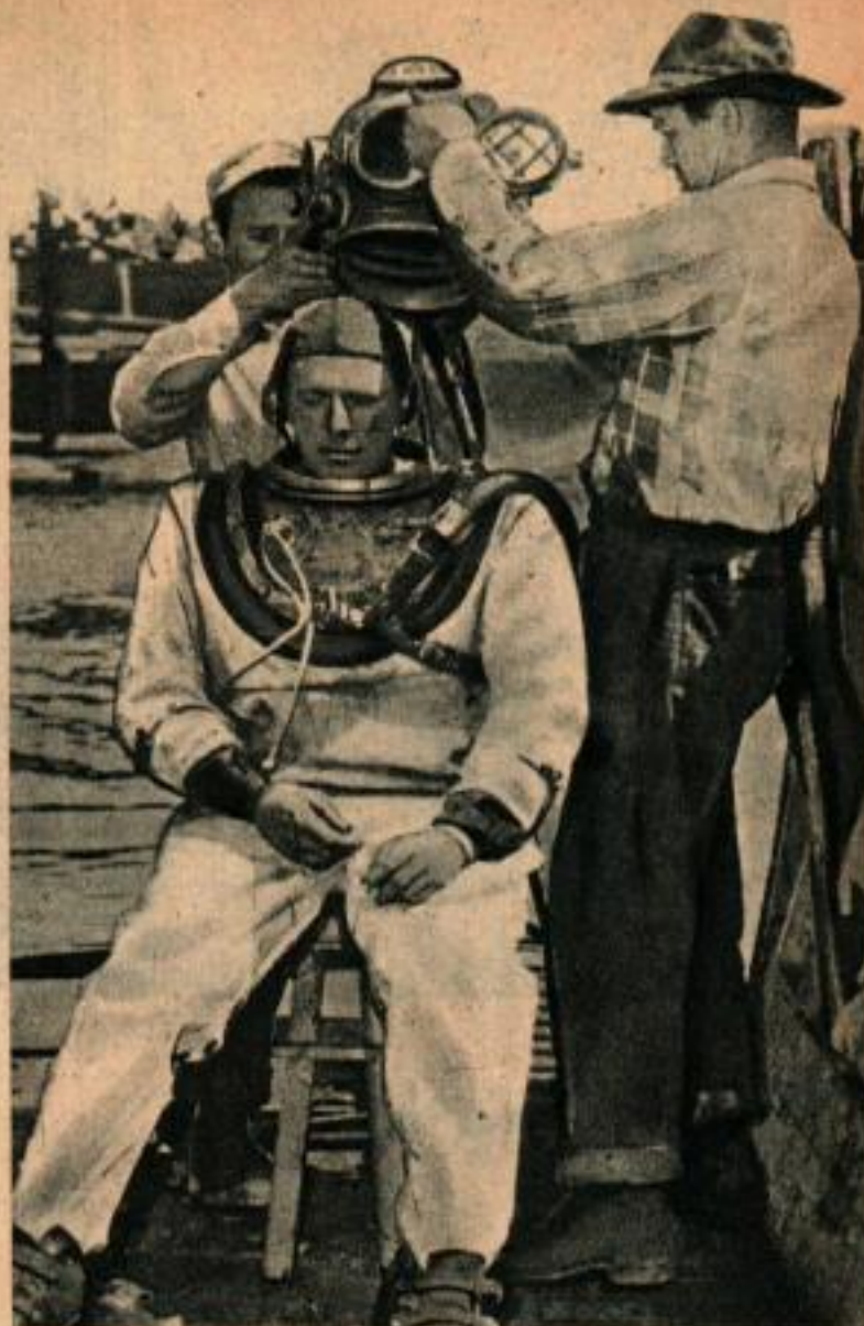
Le scaphandrier se prépare à aller chercher au fond de l'eau les troncs qui sont tellement imprégnés d'eau qu'ils ont fini par couler.
