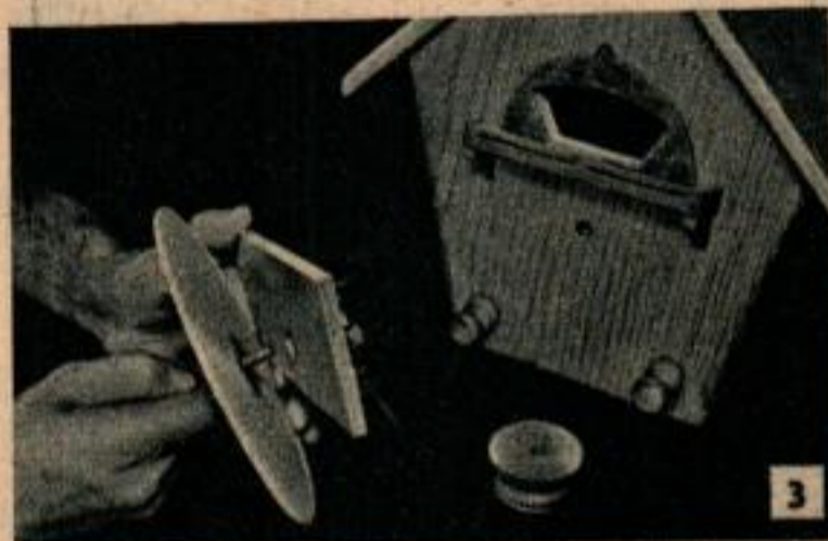
L'arbre du cadran de la radio est emmanché sur une douille qui est elle-même placée sur l'arbre de remontage de la boîte à musique.
