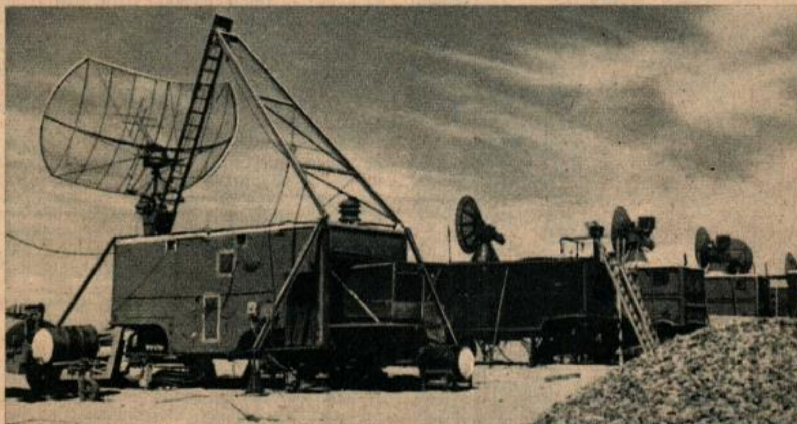
L'antenne spirale est dirigée vers le projectile pendant son vol. Elle reçoit les signaux de télémétrie qui, enregistrés, fournissent la trajectoire. Ci-dessous, ce n'est qu'une partie de l'équipement de radar utilisé pour suivre la fusée, la contrôler en vol et recevoir les signaux radio qu'elle émet.
