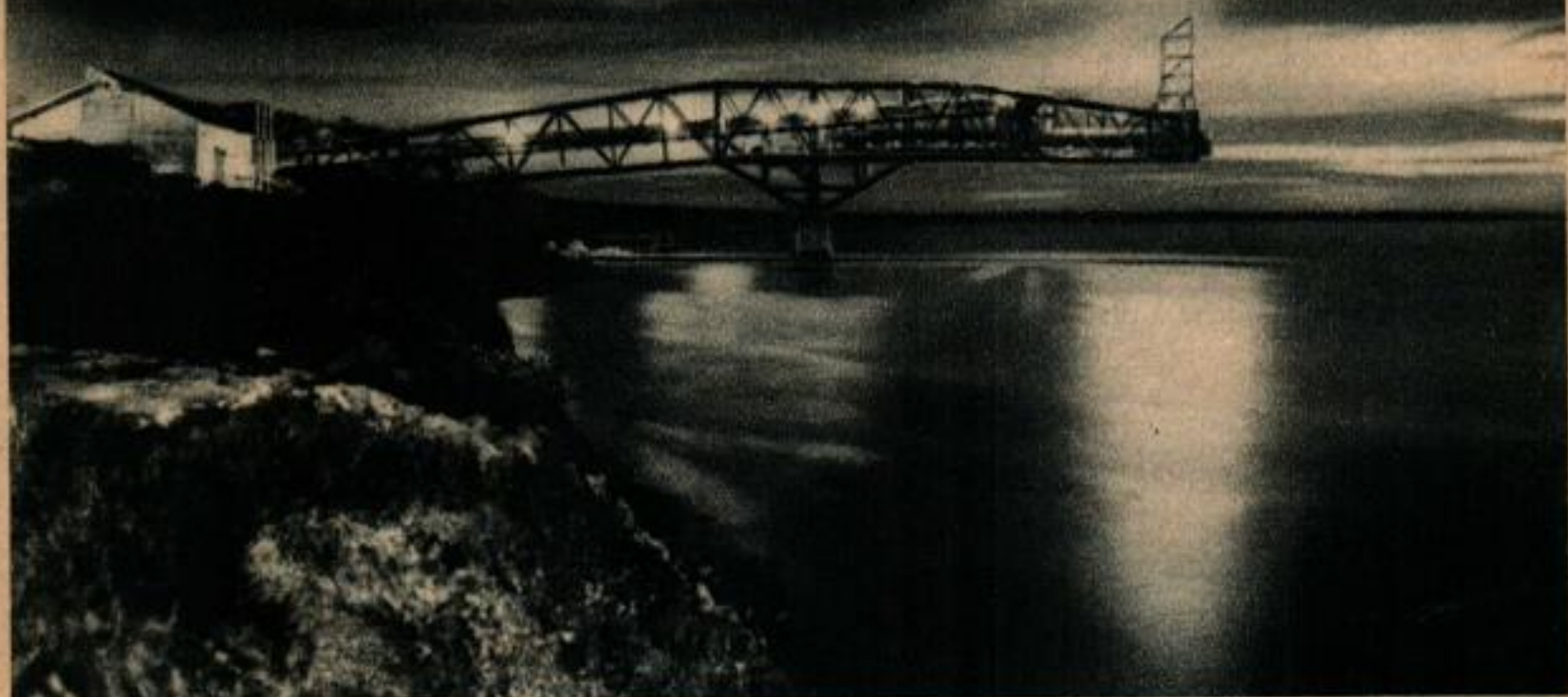
Illuminé par de puissants projecteurs, le pont de charge s'étend au-dessus de l'Orinoco. La partie de droite peut être réglée au niveau de la rivière.
