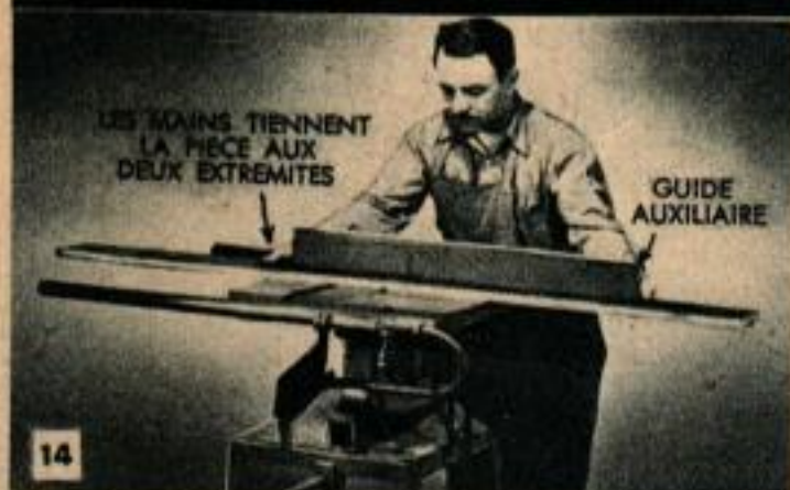
Le guide auxiliaire est utile pour scier en travers les longues planches. Pousser avec les deux mains.
