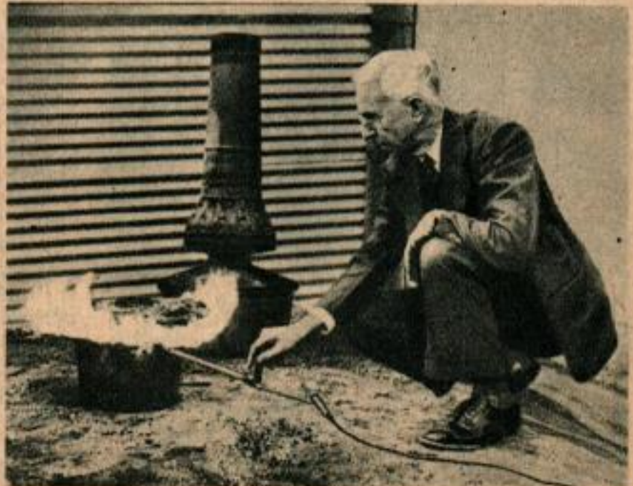
Dessin montrant le schéma du système de chauffage à pipe-line. Ci-dessous essai d'un réchauffeur par pipe-line.
