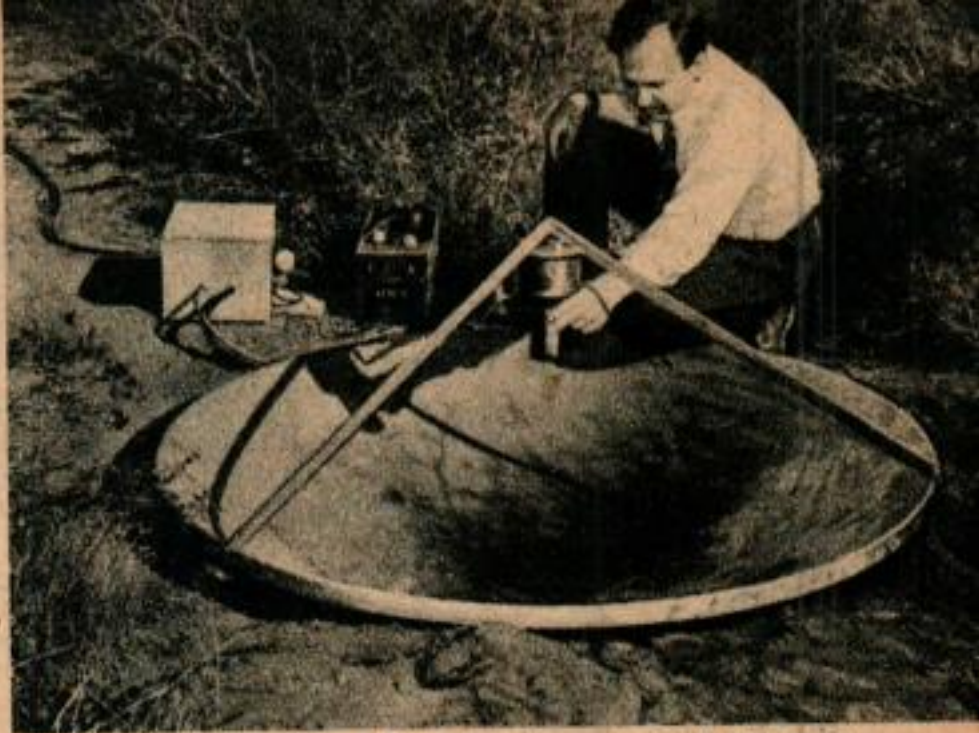
Des explosions au-dessus d'un réflecteur envoient des ondes dans la stratosphère qui les renvoie vers la terre où elles sont étudiées par les ingénieurs.
