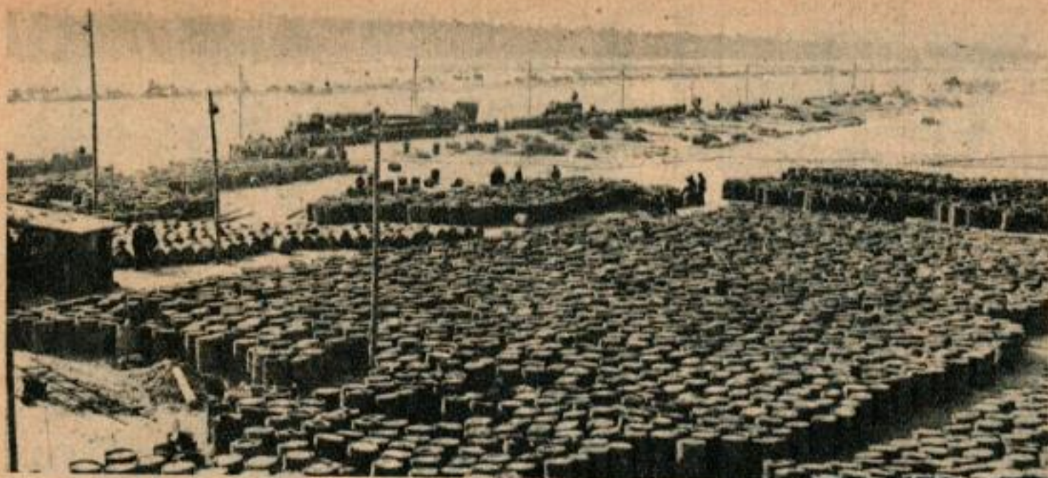
Voici une partie des 10 000 fûts d'asphalte qui ont été amenés pour achever la piste de Tegel dans le secteur français. Du gros matériel de construction a été coupé en deux au chalumeau, chargé dans des C82, puis ressoudé à l'arrivée.
