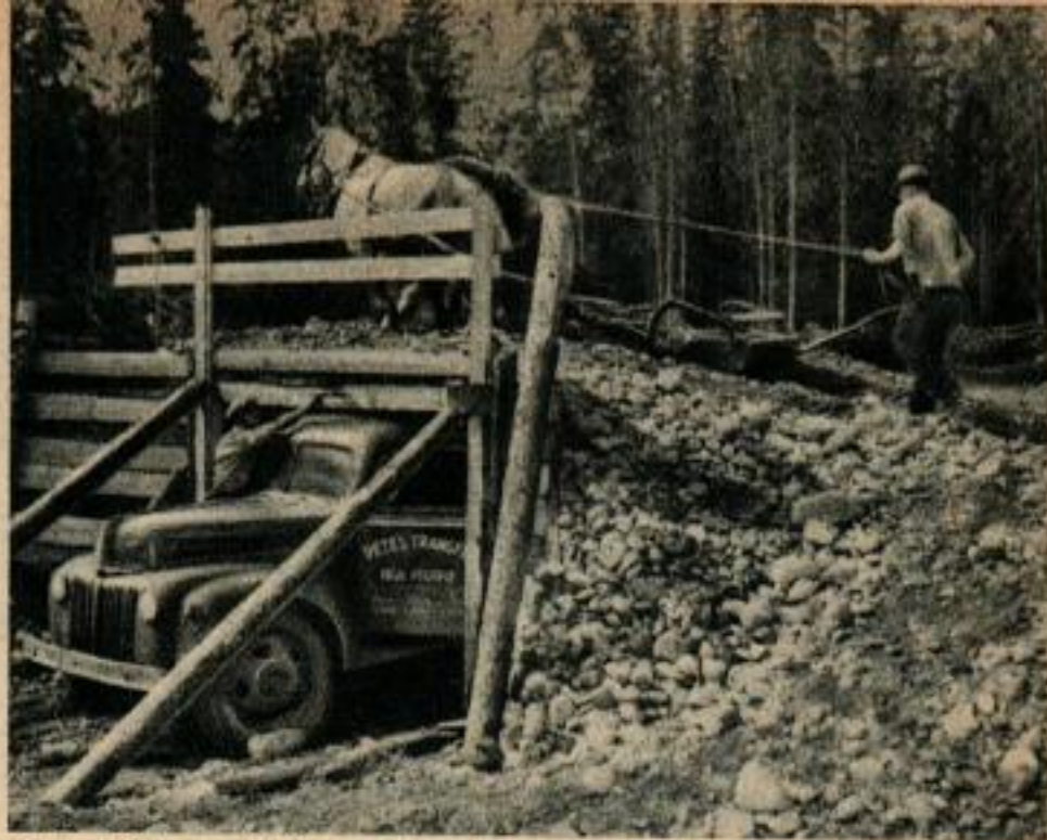
Dispositif improvisé pour charger le gravier près de High Prairie; l'ingéniosité des pionniers que l'on rencontre tout le long du chemin est proverbiale.
