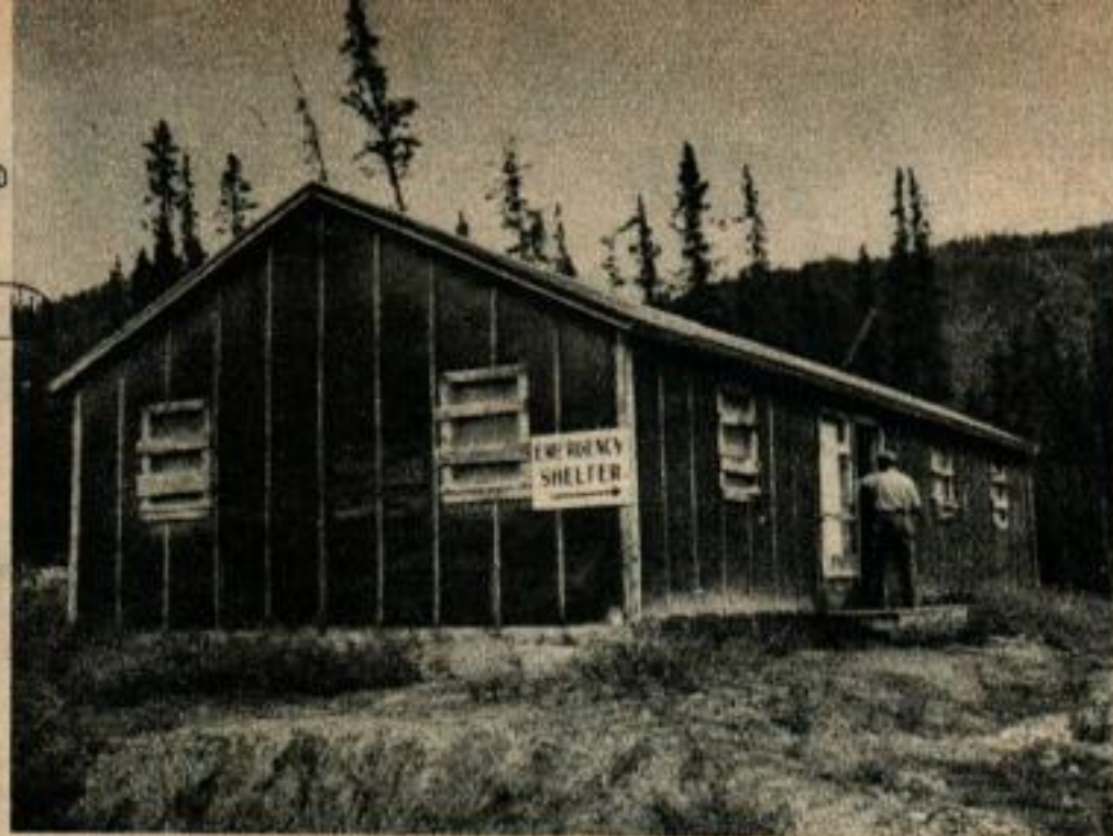
Quand on a des ennuis par 40 ou 50° en-dessous de 0, on est heureux de trouver refuge dans ces baraques abandonnées à la fin de la construction de la route.
