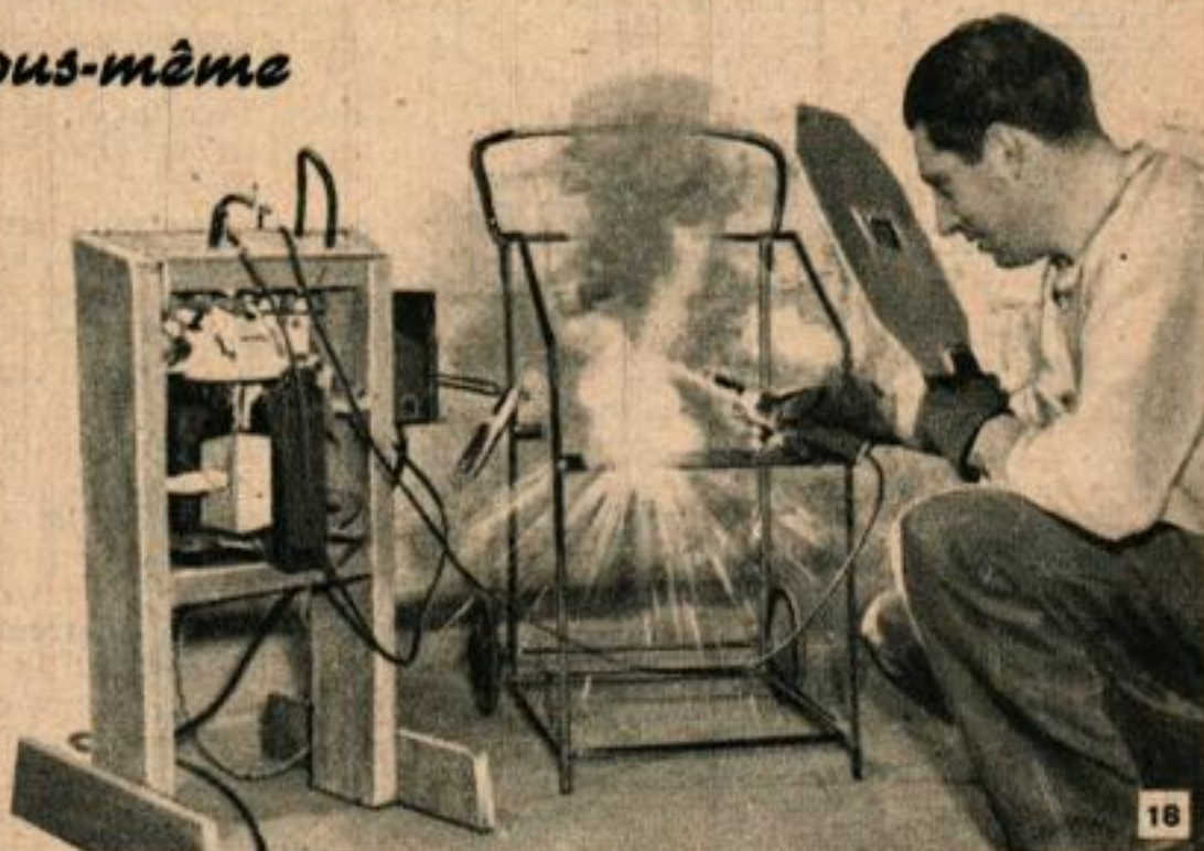
La soudeuse provisoirement montée sert à souder la carcasse.
