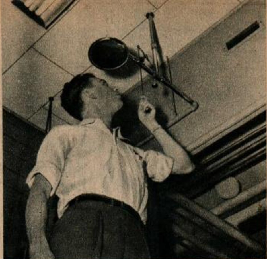
Dans le laboratoire du pétrole se trouve un dispositif de douches de secours. En cas d'explosion ou de feu, l'ouvrier tire la poignée pour que l'eau coule sur son corps.
