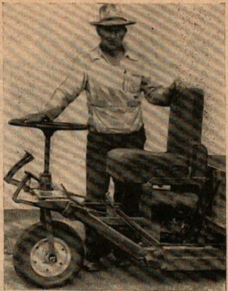
Comme vous le voyez, le chariot a un siège confortable à ressorts monté sur un cadre en cornière.
