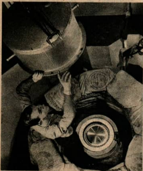
Un abri à toute épreuve utilisé pour les essais des rotors de turbines, tournant à grande vitesse et à des températures atteignant 760 deg. C. Ci-dessous et à droite, fusion d'un lingot d'un alliage magnétique nouveau. (Hiperco).
