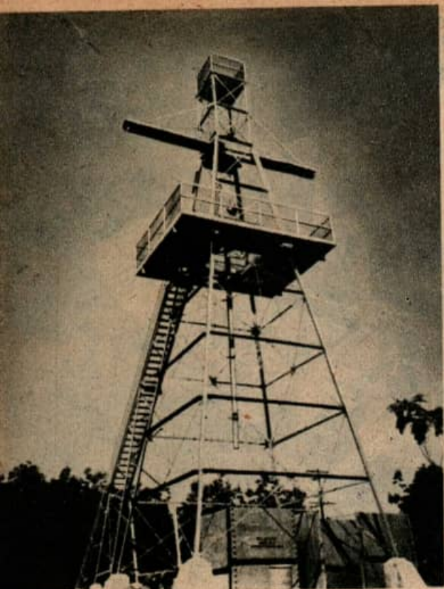
Les fusées sont placées sur des bombes inertes atteignant le poids de 500 kg, puis ces projectiles sont lâchés sur du sable ou sur des plaques de blindage du haut d'une tour de 23 m de haut (à gauche). À droite, l'atelier où sont fabriqués les prototypes des nouvelles armes.
