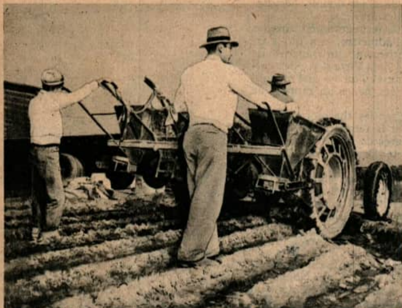
Quatre distributeurs d'engrais sont fixés derrière ce tracteur, permettant ainsi de répandre l'engrais sur quatre rangées à la fois.
