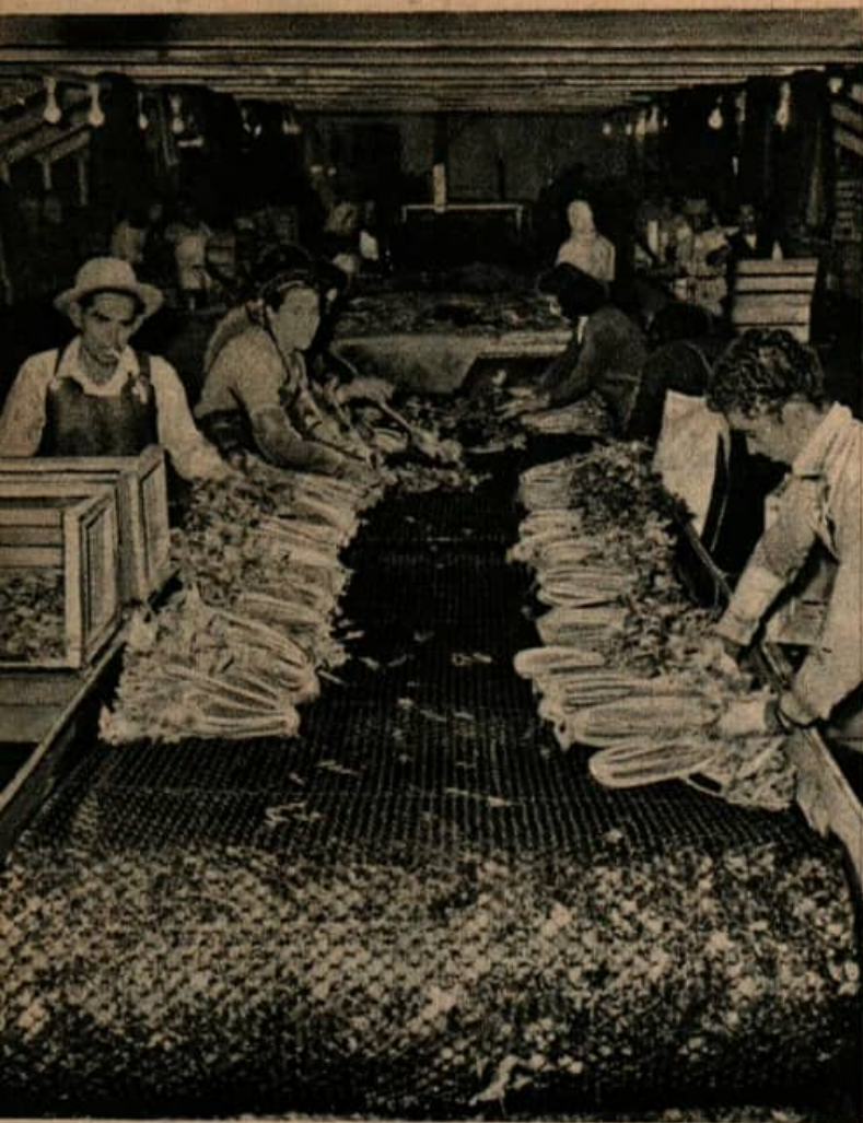
Des convoyeurs à courroies amènent les pieds de céleri devant des ouvriers qui les trient, les classent et les emballent en cageots avant de les charger en camions frigorifiques. Ci-dessous, cette remorque à plateau surbaissé a un système de levage hydraulique à main qui permet de lever ou d'abaisser le plateau quand on transporte les machines d'un champ à un autre.
