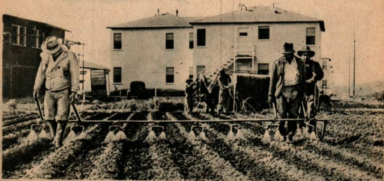
Grâce à cet arrosoir spécial, deux hommes peuvent arroser huit rangées en une seule fois tandis qu'un troisième porte la conduite d'eau. Il arrive que certaines années l'eau soit rare à Chula Vista.
