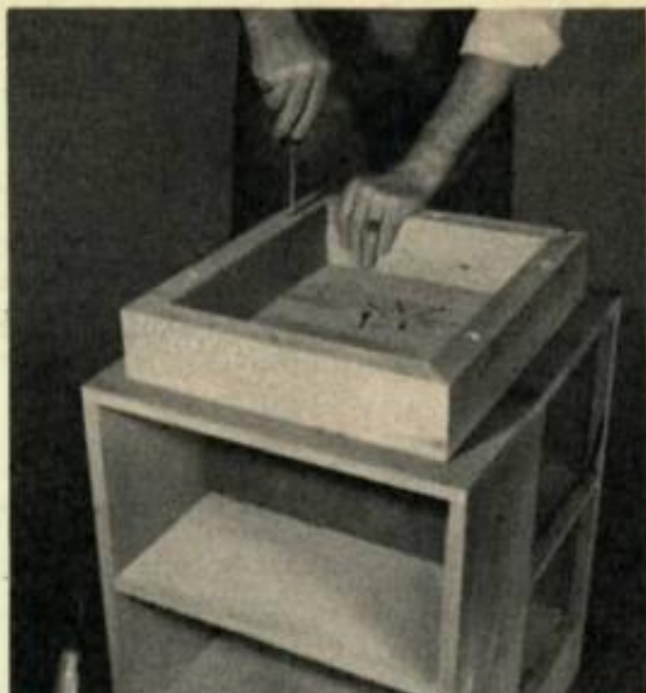
La base en retrait fait 25 x 50; ces pièces de bois sont fixées avec des vis dans des trous fraisés.
