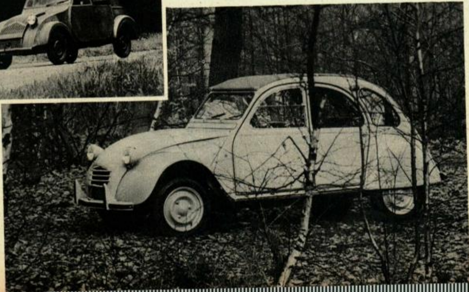
1938 — Le prototype n'avait qu'un seul phare et des roues ajourées. Son moteur était refroidi par eau. A la version 70 il faut ajouter pour les modèles qui sortent actuellement des ceintures de sécurité et de nouveaux indicateurs de direction.
