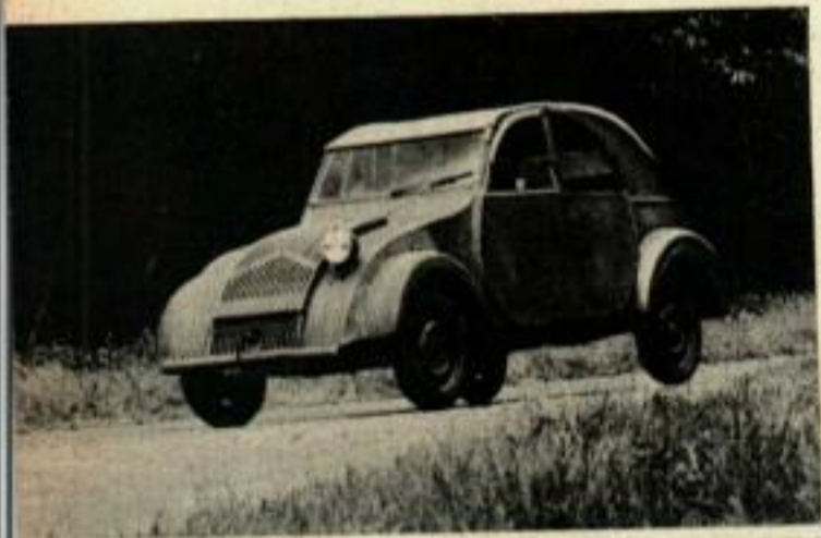
1938 — Le prototype n'avait qu'un seul phare et des roues ajourées. Son moteur était refroidi par eau. A la version 70 il faut ajouter pour les modèles qui sortent actuellement des ceintures de sécurité et de nouveaux indicateurs de direction.
