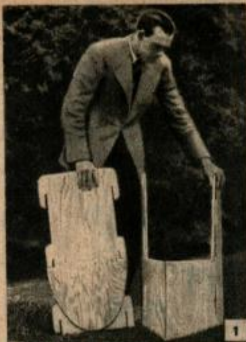
La chaise se monte en une seconde. Il suffit d'ouvrir les côtés, de lever le siège, d'insérer le dossier dans les fentes et de le pousser vers le bas pour faire tenir les pièces entre elles.
