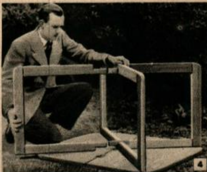
Joint à recouvrement collé
