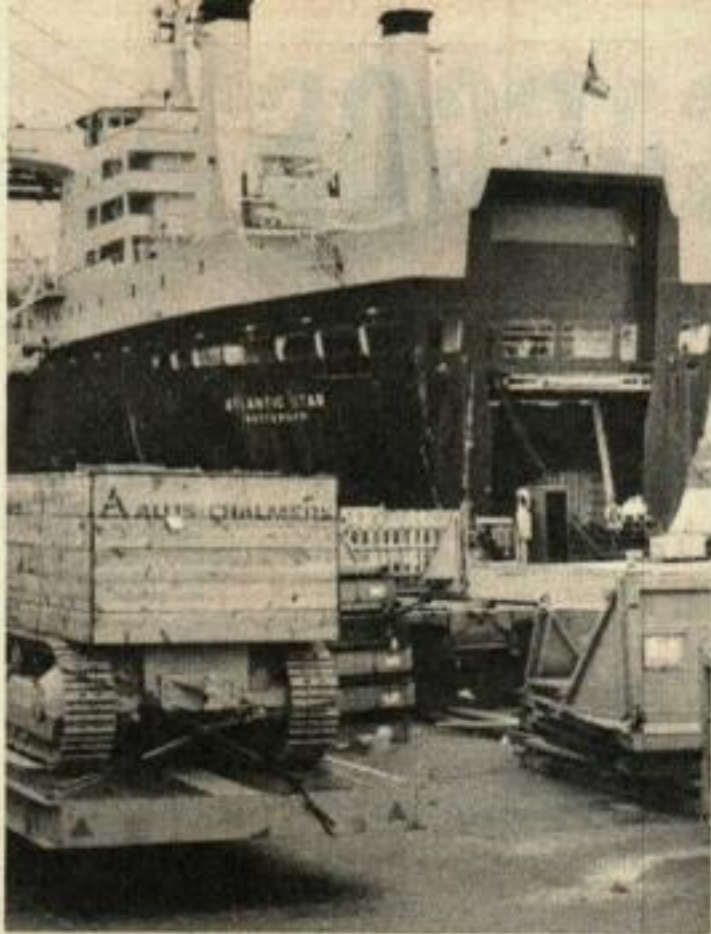
Sur la rampe d'embarquement, une semi remorque pénètre en roulant dans l'énorme cale du bateau.
