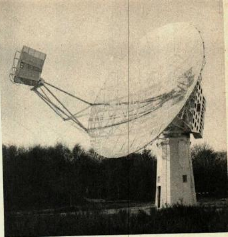
L'antenne du Centre Spatial Guyannais destinée à suivre la trajectoire des lanceurs et à recueillir les signaux qu'ils émettent. C'est une antenne de télémétrie à poursuite automatique fonctionnant dans la bande de 216 à 260 MHz.
