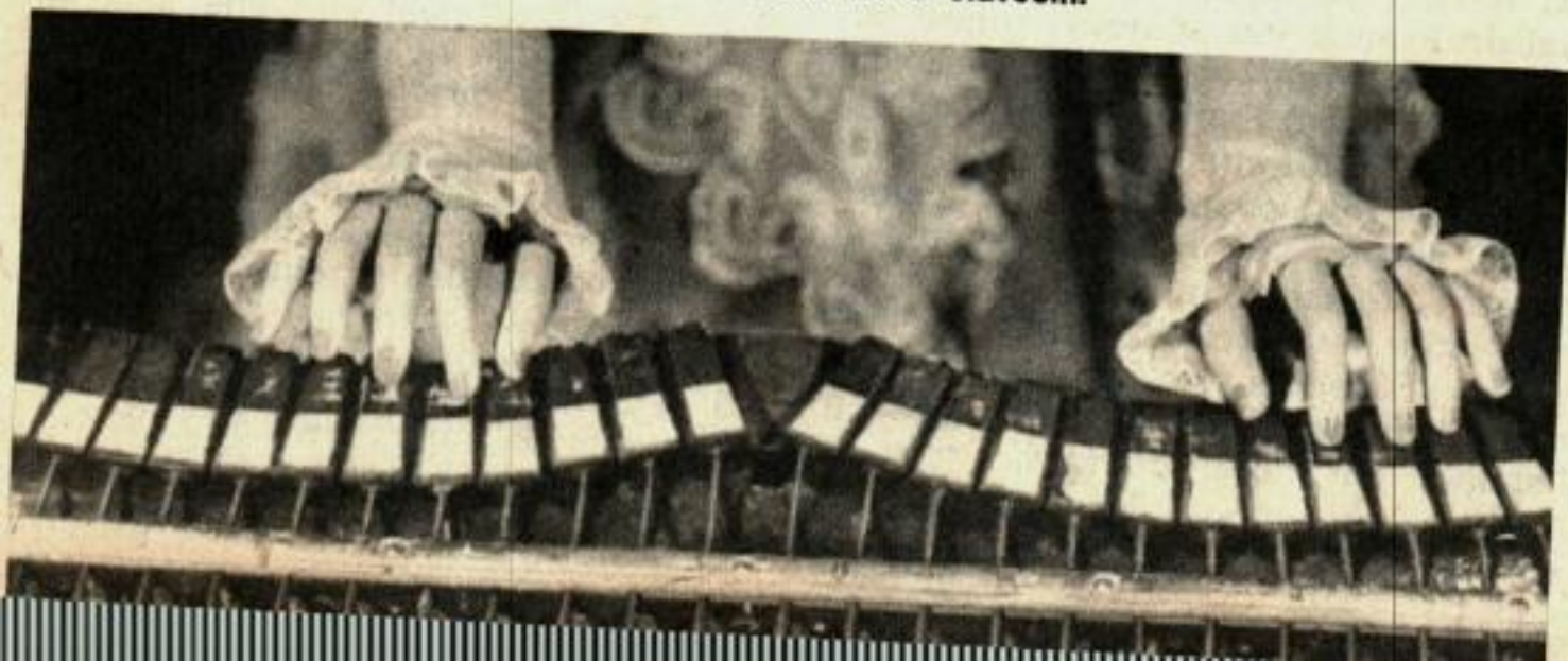
Les doigts de la « claveciniste » sont de gracieux leviers mus par des disques — un autre mécanisme actionne le clavecin.
