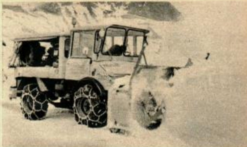
La double turbine Unimog « 406 ».
