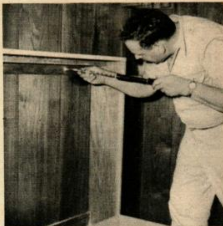
LE PLACARD DU LIT est fixée au mur et aux montants tout d'abord avec des vis enfoncées à travers les tasseaux du haut et du bas.
