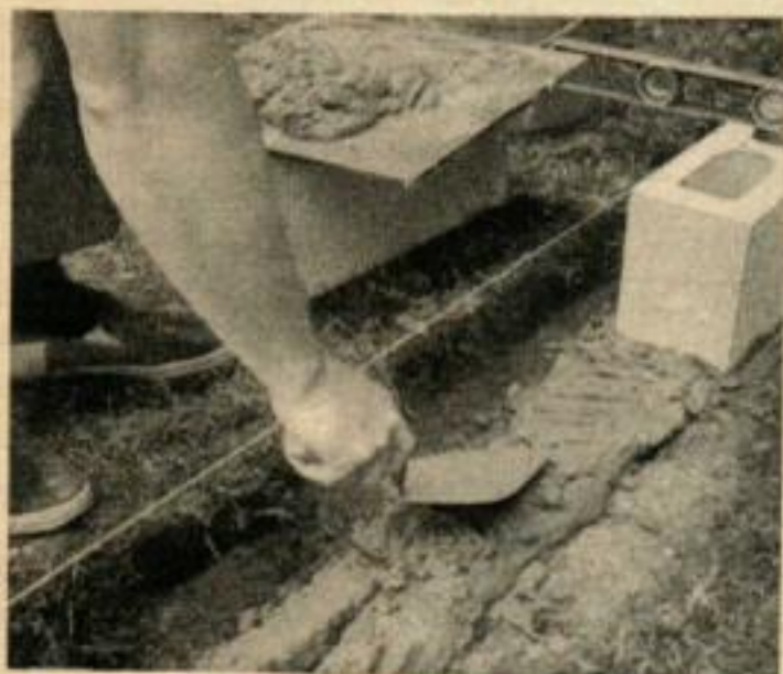
LA PREMIERE RANGEE est posée sur une couche de mortier qu'on a sillonnée avec la pointe de la truelle. Notez la ficelle d'alignement.
