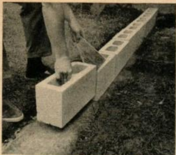
UN ALIGNEMENT à sec des blocs sur la fondation est une bonne précaution. Utiliser des morceaux de contre-plaqué de 10 mm comme cales.
