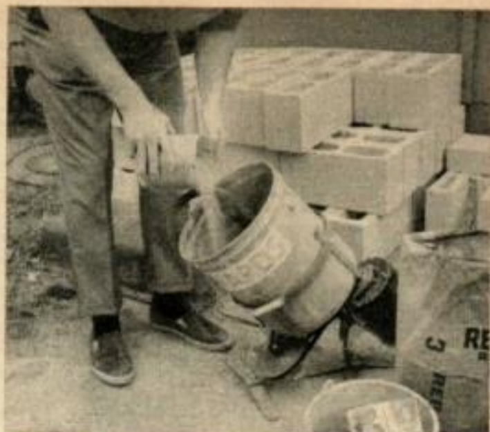
UN PETIT MELANGEUR de béton vous permet de préparer une nouvelle provision de mortier tandis que vous utilisez le premier lot.
