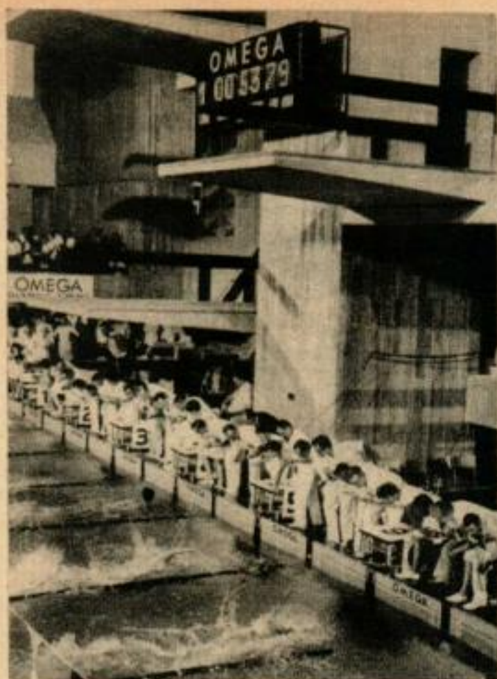
DANS CETTE PISCINE OLYMPIQUE, des plaques de contact sont montées à l'arrivée de chaque couloir. Quand un nageur touche une plaque à l'arrivée, son temps est automatiquement et exactement chronométré. Ce temps est ensuite montré sur un tableau surélevé, à 1/1000 e de seconde près.
