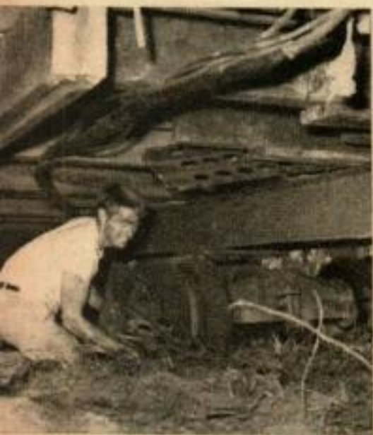
SUR UN TERRAIN MOU , les roues sont soutenues par des grillages métalliques du genre utilisé pour les pistes d'atterrissage improvisées. Le montage sur trois boggies (schéma) évite de mettre la maison en porte-à-faux.
