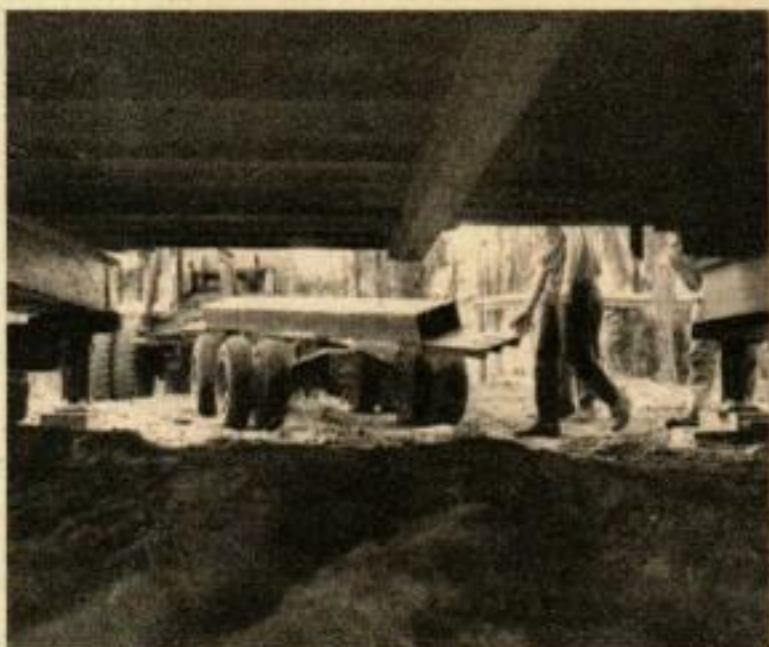
LA MAISON ETANT POSEE sur chantier, les boggies sont dégagés. Les fondations sont ensuite surélevées en dessous et la maison est posée doucement dessus avec les crics.
