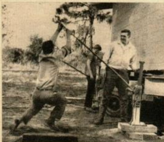
SUR LE NOUVEL EMPLACEMENT , la maison est soulevée sur des crics pour pouvoir enlever les boggies. Elle est ensuite posée sur des chantiers temporaires.
