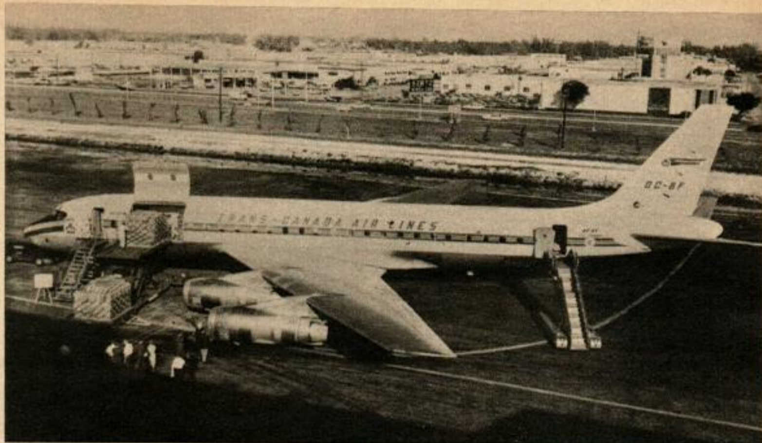
D.C. 8 F. Cargo qui peut transporter jusqu'à 43 tonnes de fret à 900 km/h.
