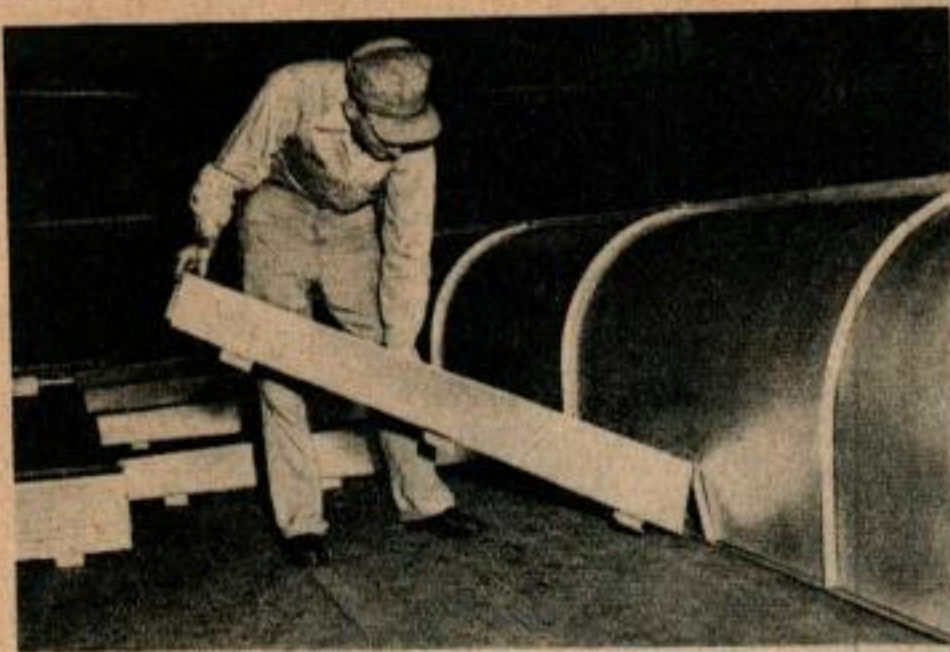
Ce sécheur de récolte distribue la chaleur à travers le foin. Les conduits peuvent être retirés et stockés lorsqu'on n'en a plus besoin.
