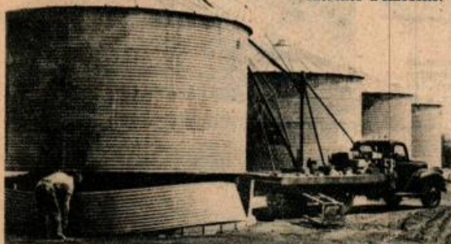
Construction de silos à grain destinés aux recherches d'efficacité.
