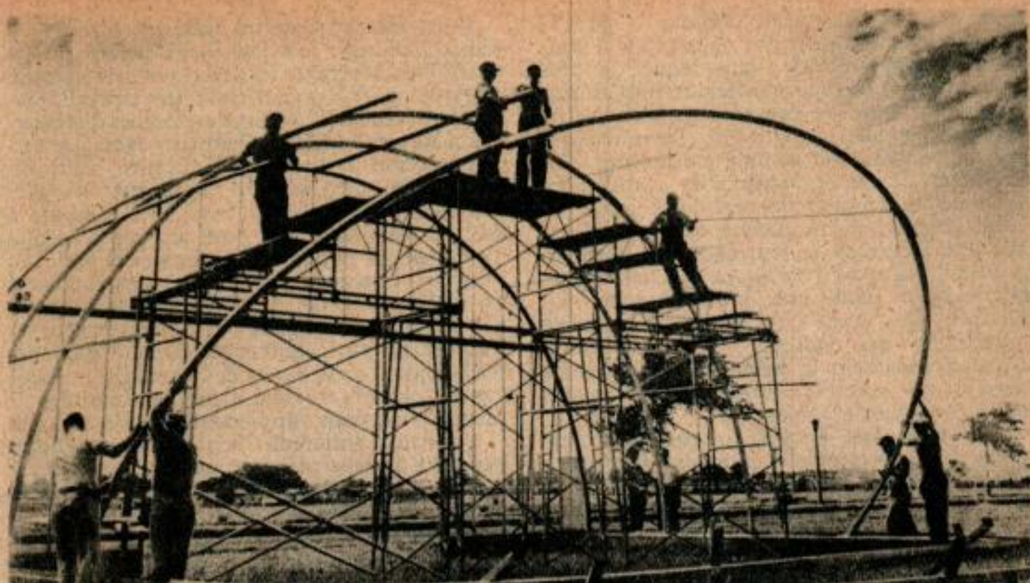
Des arches supplémentaires sont fixées ensemble sur le sol puis levées et maintenues en place par des barres d'espacement.
