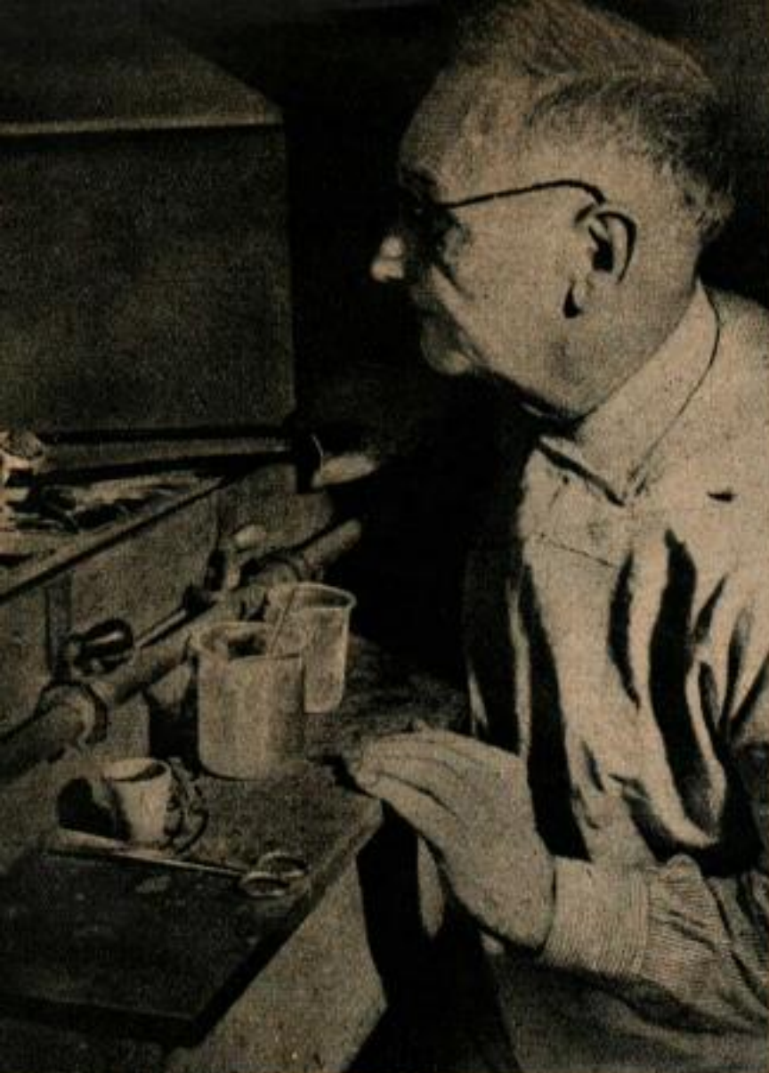
Les débris des plantes sont réduits en cendres par chauffage. L'expert détermine d'après le spectrogramme la nature des éléments présents.
