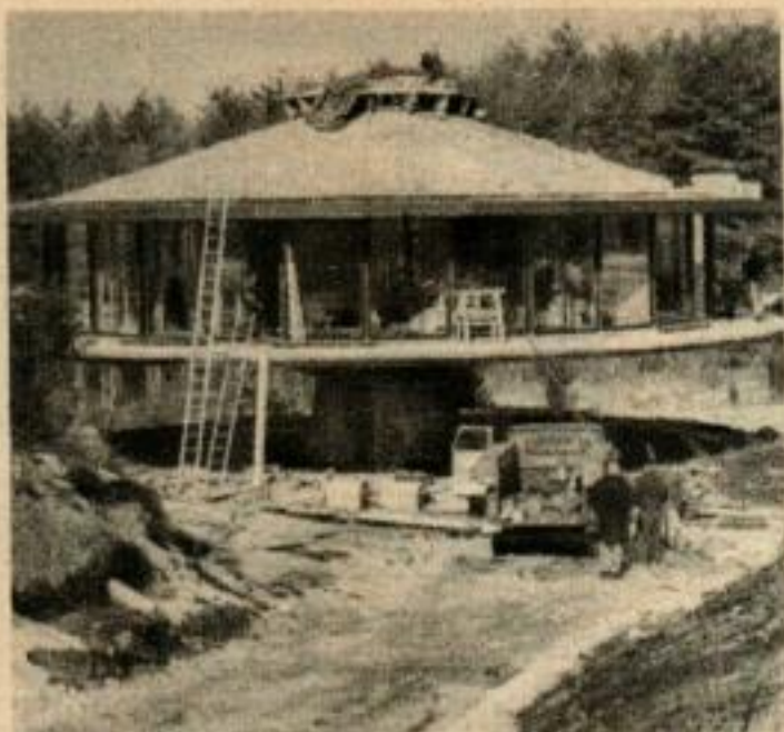
CES PHOTOS SONT PRISES EN COURS DE CONSTRUCTION. La maison sera achevée cet été, trop tard pour être représentée comme telle ici. La balustrade du balcon n'est pas encore en place. Le dessous a été doublé et couvert de contre-plaqué mais les bardeaux ne sont pas encore posés.
