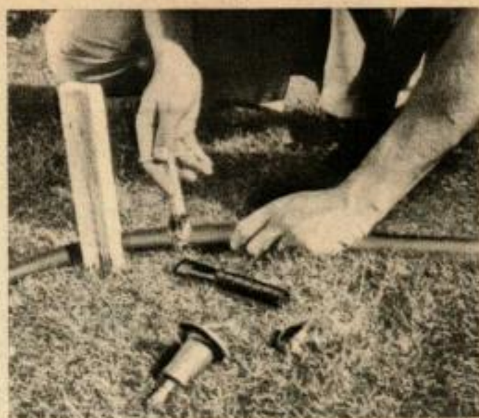
UN OUTIL SPECIAL perce un trou dans le tuyau à l'endroit où doit être montée une tête d'arrosage. La hampe est ensuite fixée avec un étrier.
