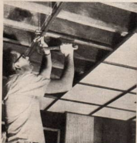
LES LONGERONS INTERMEDIAIRES sont cloués directement sur les solives. On peut se servir des barres transversales pour les espacer exactement.
