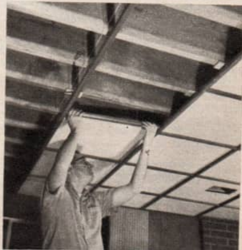
LES PANNEAUX DECORATIFS sont mis en place, puis calés avec des barres transversales assorties.
