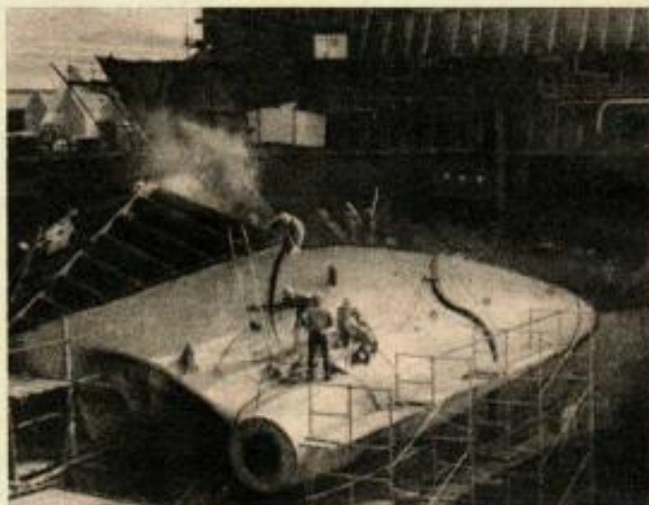
LE PALIER COMMUN des deux hélices : le tirant d'eau de 22 mètres ne permet pas d'obtenir un bon rendement hydraulique avec une seule hélice.
