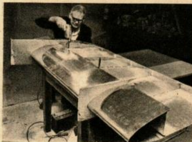
CALVIN PARKER perce des trous de rivet dans le bord d'attaque de l'aile qui est maintenant en place par une pièce échancrée de contre-plaqué.
