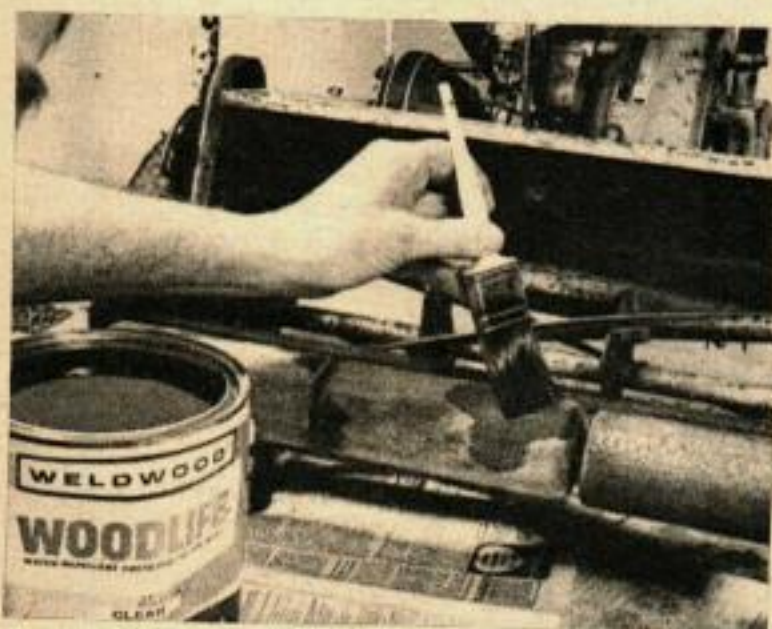
LES ROULEAUX EN BOIS des tondeuses à moulinet sont imprégnés de produits de protection.
