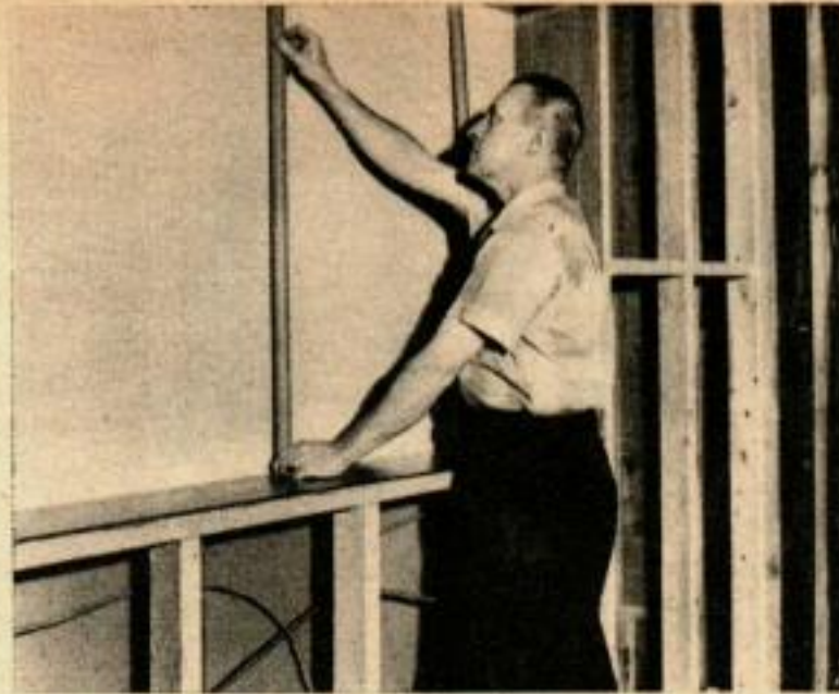
LE PREMIER PANNEAU est encastré dans les rainures de la moulure. Progresser de gauche à droite en laissant un espacement de 6 mm au plancher.
