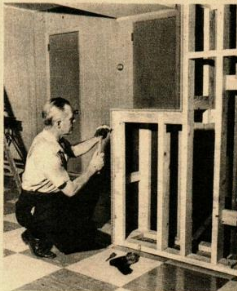
LES BORDS DES PLANCHES sont cachés aux coins par une moulure métallique assortie qui est clouée sur la charpente.
