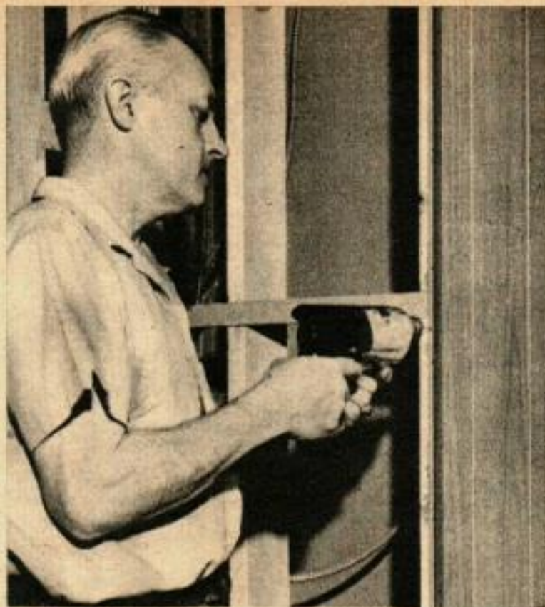
LA CHARPENTE DU SOCLE DE PLANTES est montée contre le bout du nouveau mur. Le haut est laissé ouvert pour recevoir un bac de tôle de 1 m 20 de profondeur.
