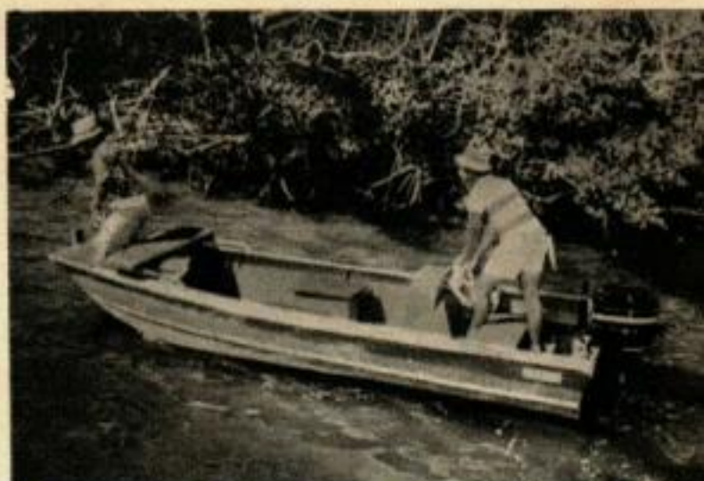
LE MONARK PRO est un bateau de servitude de 4,60 m à faible tirant d'eau, avec une carène en V modifiée. Le siège qui est tout à fait l'avant peut être facilement réglé ou démonté. La monture avant pour moteur de faible allure est normalement fournie par Monark Boat Co, Monticello, Ark. 71.655.
