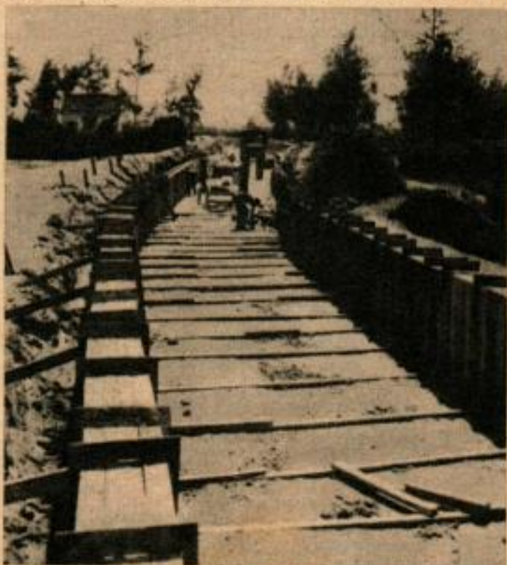
LES PLUIES DILUVIENNES qui règnent au Vietnam exigent la construction de caniveaux pour empêcher les eaux de saper les routes et les pistes d'envol.
