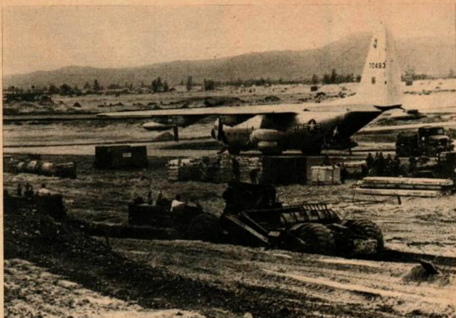
LA PRINCIPALE TACHE DES SEABEES est la construction de nouvelles bases aériennes et de cantonnements confortables pour les troupes.
