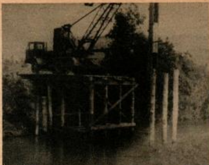
CE BELIER IMPROVISÉ a été utilisé pour enfoncer des troncs d'arbre dans une rivière torrentielle pour la construction d'un pont.
