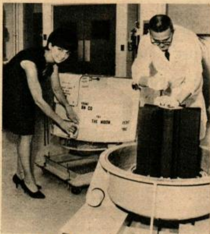
CE - GENERATEUR LUNAIRE - est emballé dans une cellule spéciale pour le protéger pendant la première partie du trajet qui doit le porter sur la surface de la Lune.
