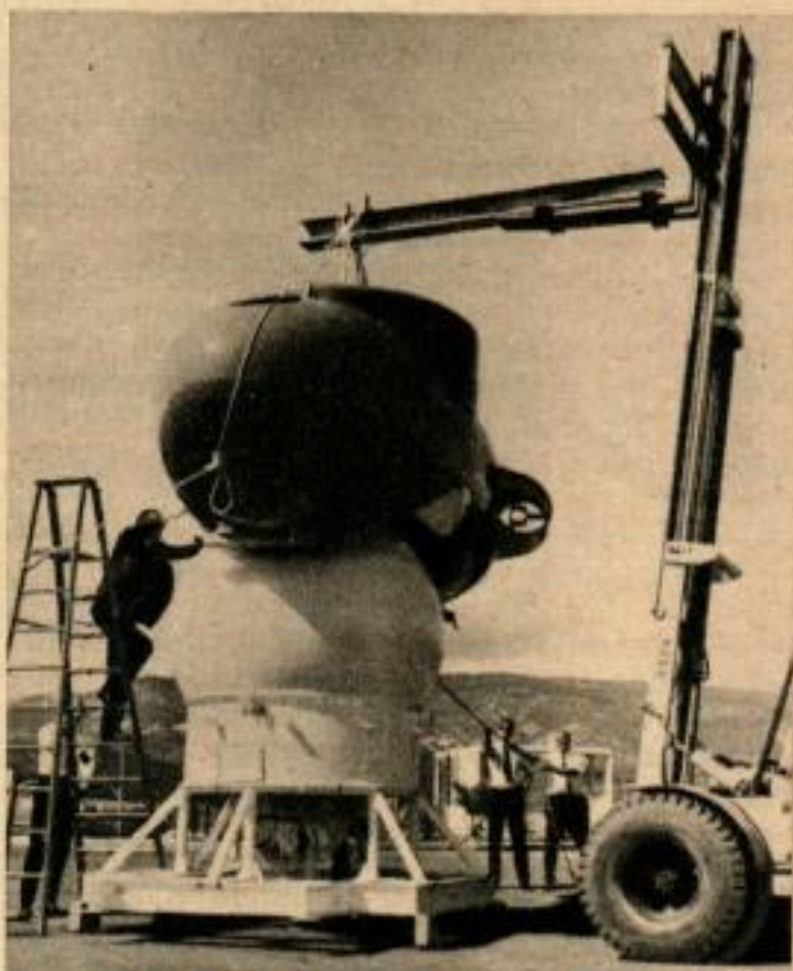
UN CARENAGE EN FIBRE DE VERRE est placé sur le DOWB (Deep Ocean Work Boat) qui a un équipage de deux hommes qui peuvent y séjourner en toute sécurité à une profondeur de 2 000 mètres pendant 65 heures. Construit par la General Motors AI Electronics, ce sous-marin biplace a 5,20 m de long, une autonomie de 50 km, une visibilité panoramique grâce à des systèmes optiques directs et une caméra spéciale de TV pour explorations sous-marines.
