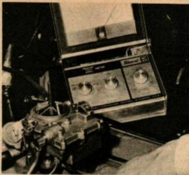
LA PROPORTION D'ESSENCE DANS L'AIR (ou « richesse » du mélange) est réglée sur l'allure de ralenti quand le moteur est chaud pour l'empêcher de caler de nouveau.
