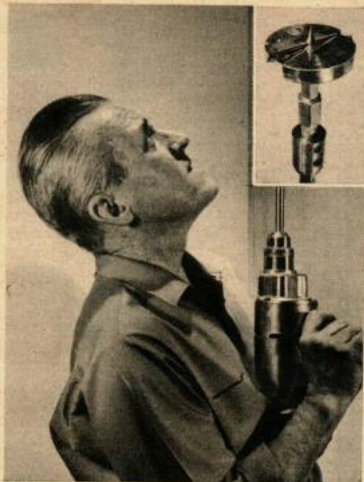
LE DECOUPEUR DE TROUS (petite photo) placé au bout d'une tige permet de percer le plafond et la poutre sans effort, si l'on possède une perceuse.
