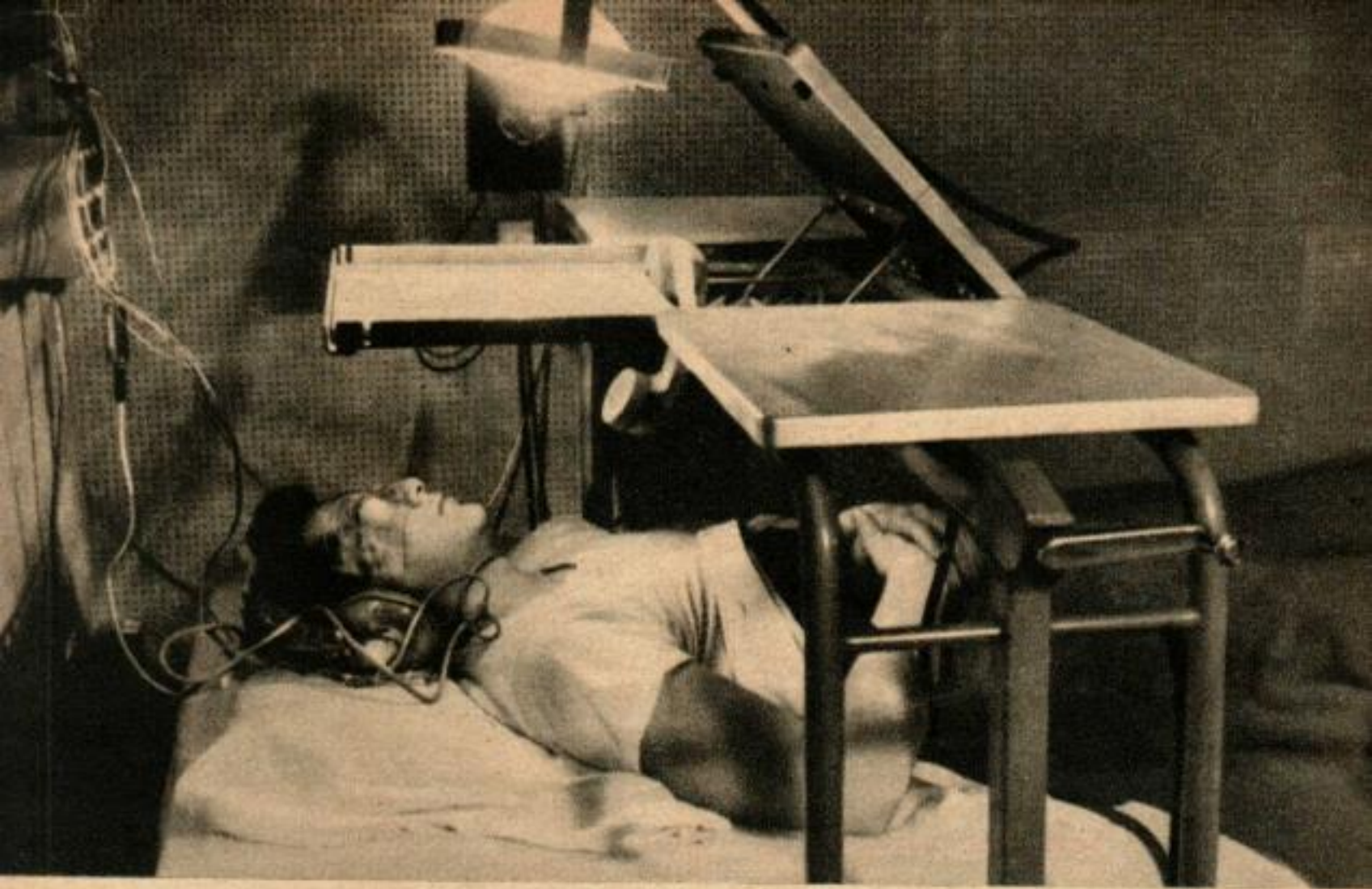
CE DORMEUR VOLONTAIRE a des électrodes fixées sur la peau du crâne et les yeux pour l'enregistrement de l'activité cérébrale et des mouvements des yeux.
