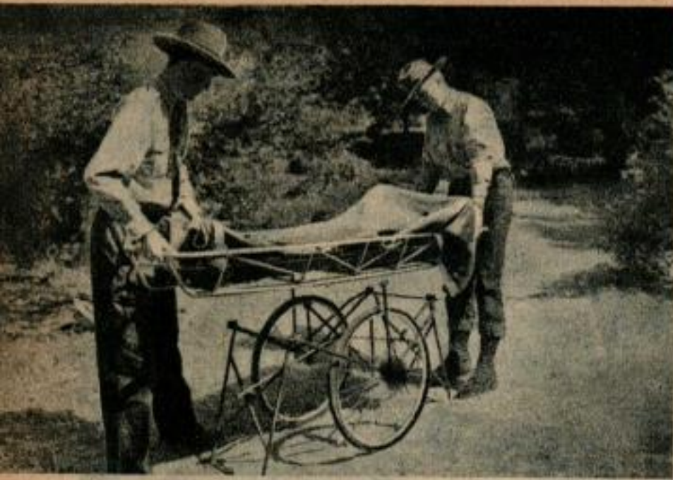
Petite civière légère utilisée à Yosemite pour le transport des blessés et des accidentés. Deux hommes suffisent à la conduire lorsqu'elle est chargée, alors qu'il en faut six pour les civières ordinaires.
