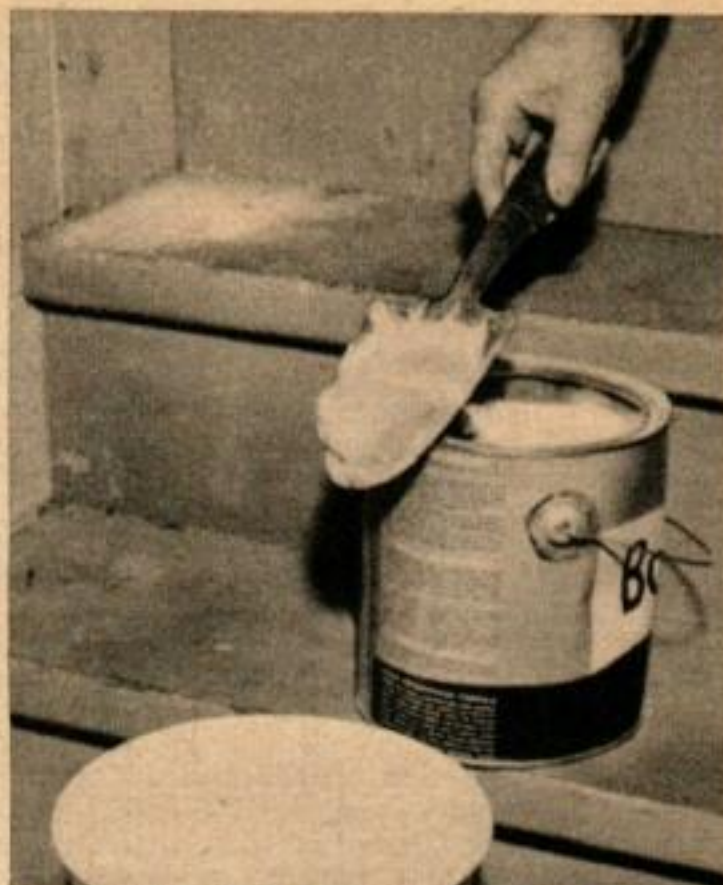
LA PEINTURE AU CIMENT de Portland est vendue sous forme de poudre que l'on mélange à l'eau.
