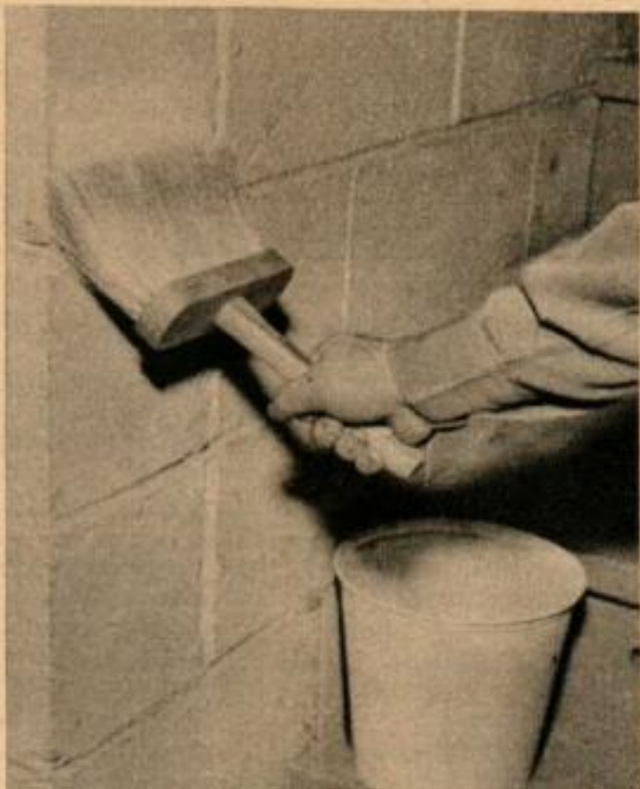
NETTOYER A FOND LA SURFACE avec une brosse métallique avant d'appliquer une nouvelle couche de peinture sur une maçonnerie déjà peinte.
